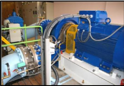
Figure 15 : Microturbine installée dans les locaux du réservoir de Cap de Croix à Nice
